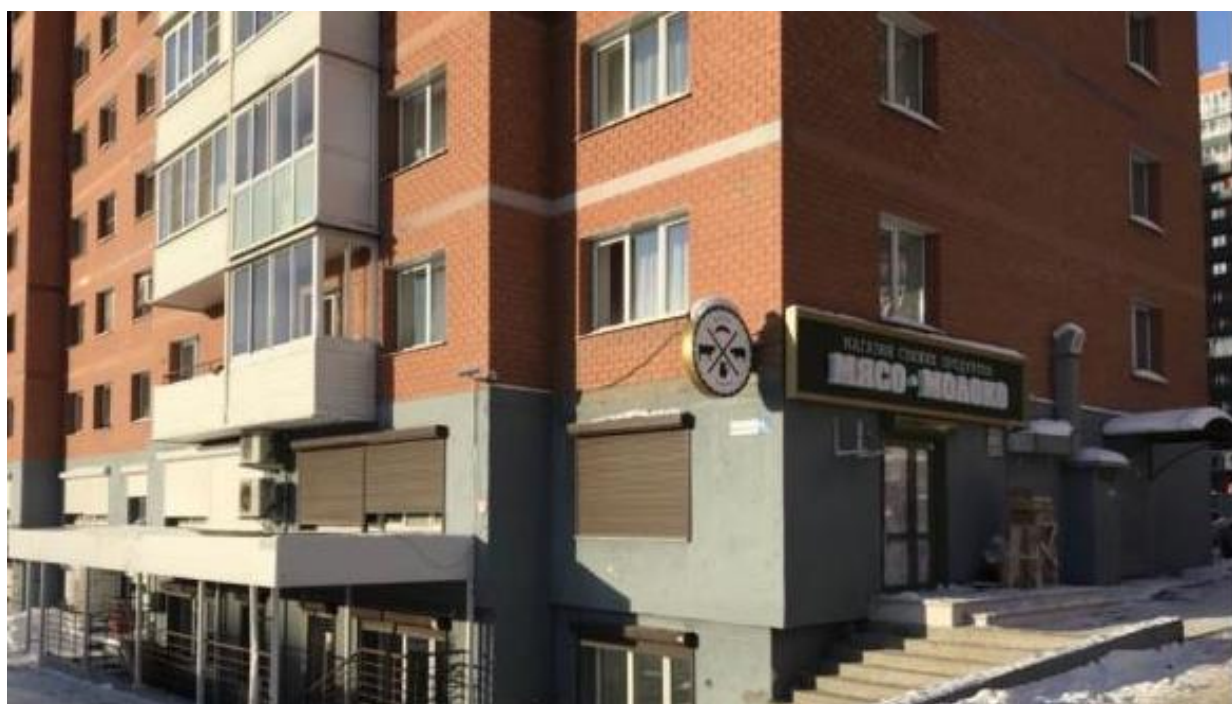
Рис 1.2. Здание по ул. Дыбовского, 8/13 со стороны улицы
